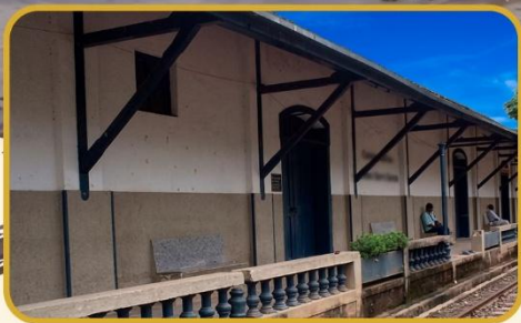
ESTAÇÃO FERROVIÁRIA DE MUQUI
